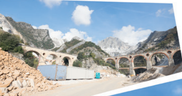
INACTIVE - PONTI DI VARA'S QUARRY - NOW
