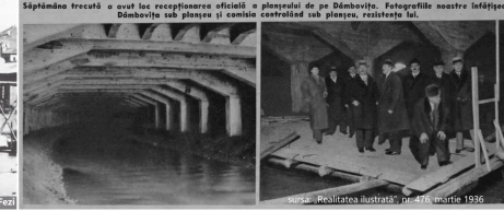
„Săptămâna trecută a avut loc recepționarea oficială a planșului de pe Dâmbovița. Fotografia noastră înfățișează Dâmbovița sub planșul și comisia controlând sub planșul, rezistența lui.”
