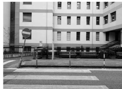
2. Spazio di sosta prospiciente l'accesso al padiglione di Libera Professione - Senologia, Viale della Maternità
