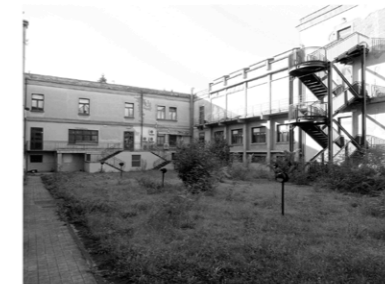
11. Corte con area verde in stato di abbandono, Via della Solidarietà
