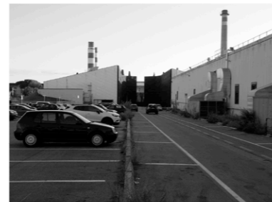
9. Parcheggio pubblico prospiciente la Lavanderia e la Centra di Sterilizzazione, Viale San Luca
