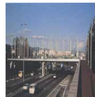
Conexión de dos barrios en la Gran Vía / Connection of two neighbourhoods on the Gran Vía Sant Adrià del Besòs, España / Sant Adrià del Besòs, Spain Sergi Godia, Berta Barrio
